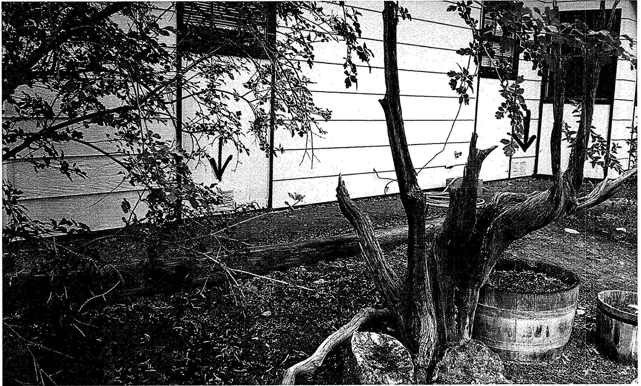
VENTS S. SIDE
